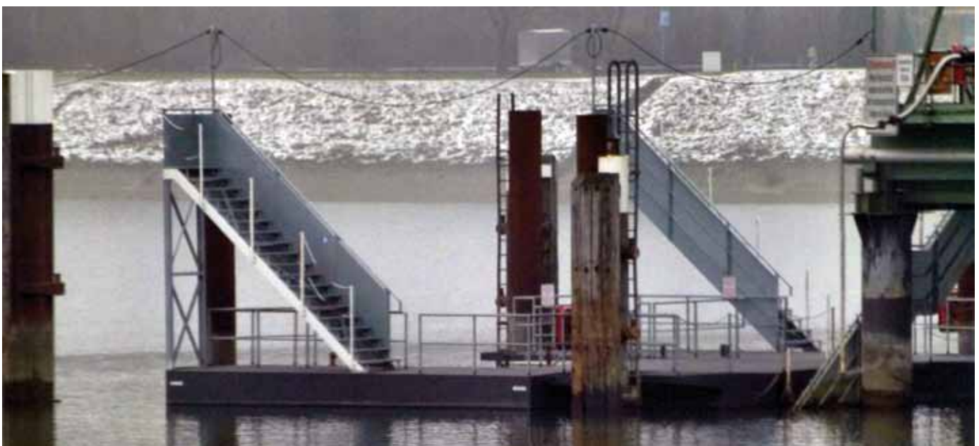
Zwei bei allen Wasserständen nutzbare Fluchtwege im Oberrhein-Hafen
