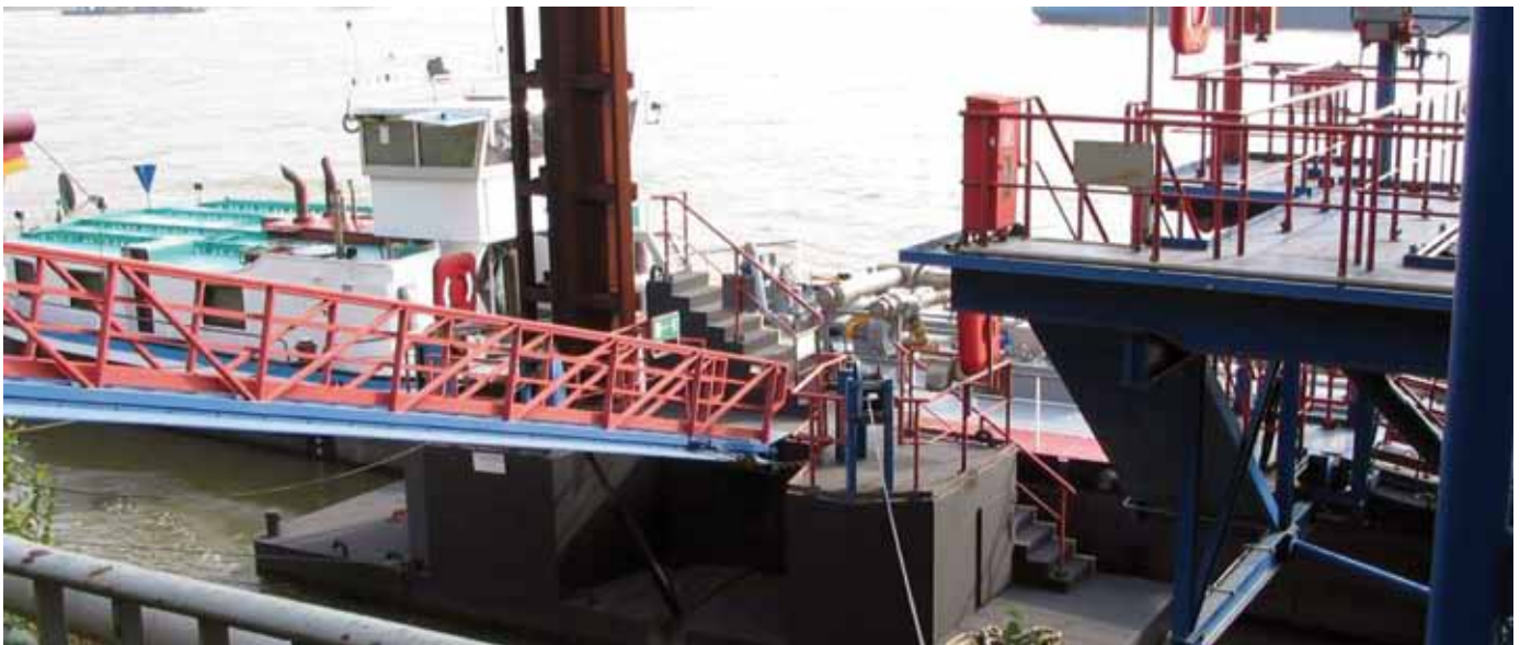
Achterer Zugang und Fluchtweg auch bei langen Schiffen nutzbar
