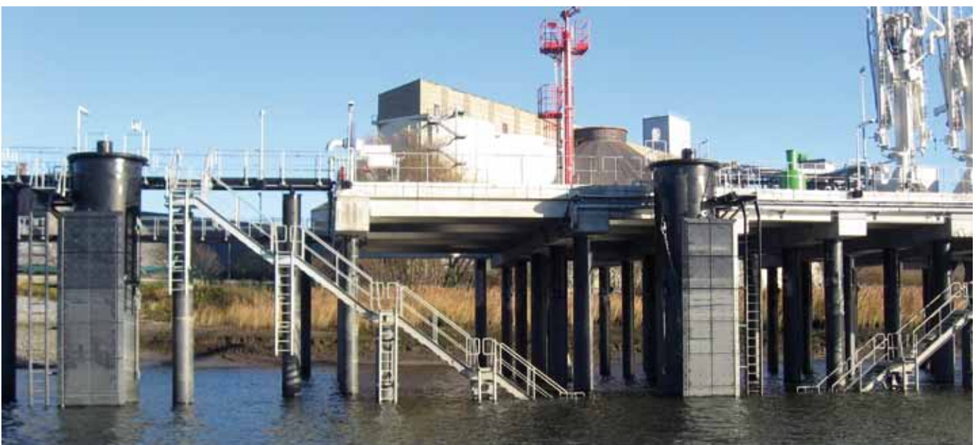
Fluchtwege-Lösung für wechselnde Wasserstände im Seehafen
