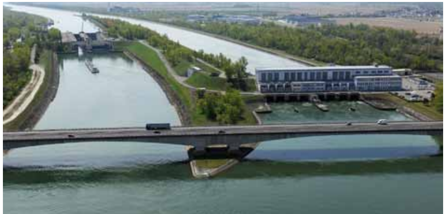
Kleine Schleusenammer von Ottmarsheim – April bis Ende Oktober 2013. 700.000 Euro. Renovierung der Betätigungsmechanismen des Obertores, Ersetzung der Abdichtung des Obertores, Wartungsarbeiten an den Entleerungs- und Füllschützen der Schleusenammern, Verbesserung des Schließsystems der Tore
