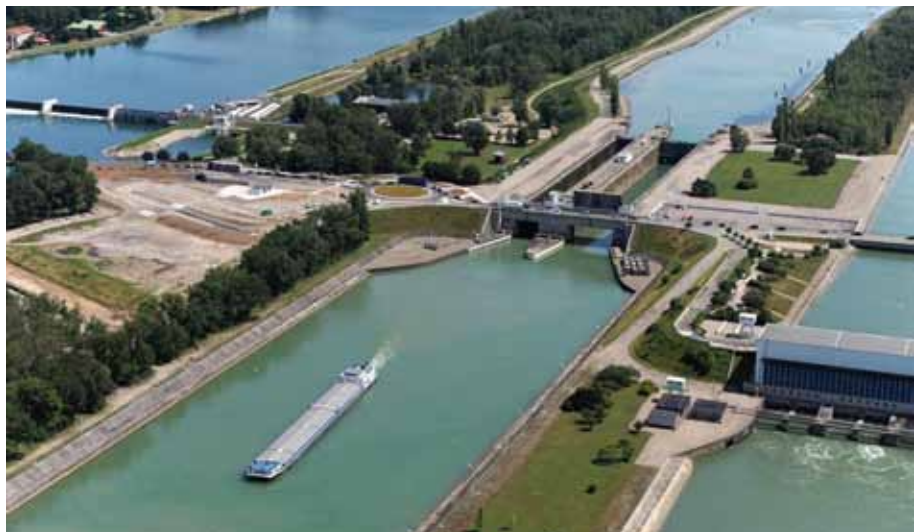
Kleine Schleusenammer von Vogelgrün. April bis Ende August 2013. 1,2 Mio. Euro. Farb-anstrich des Obertores (Asbestsanierung, Metallisierung, Farb-anstrich), Ersetzung der Abdichtung des Obertores, Modernisierung des Hebemechanismus des Untertores, Wartungsarbeiten an den Entleerungs- und Füllschützen der Schleusenammern, Verbesserung des Schließsystems der Tore
