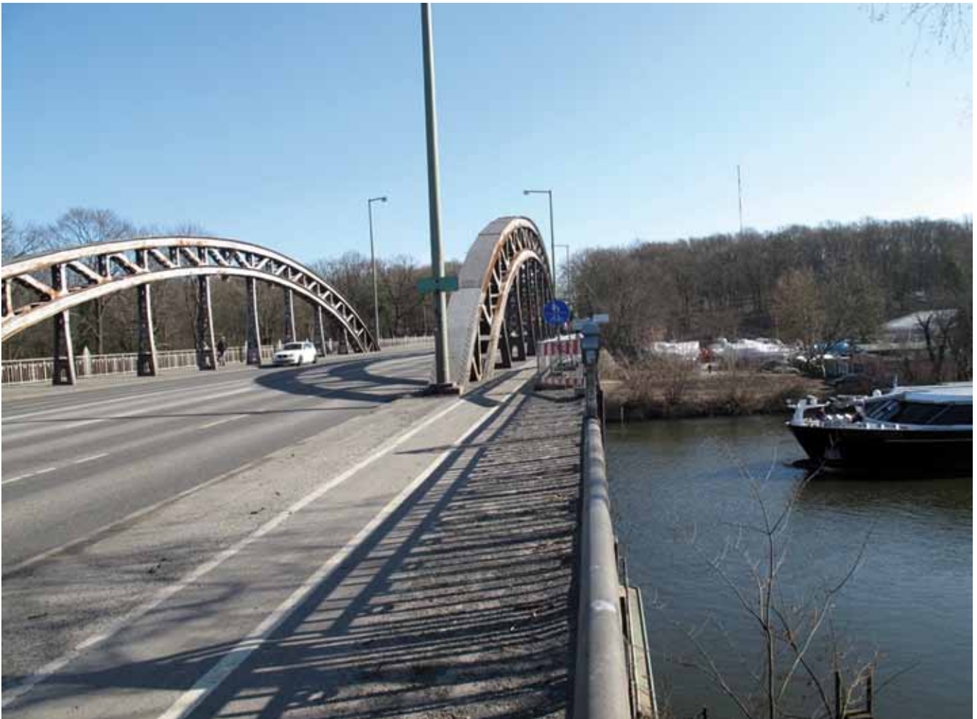
Mit dem Neubau erfolgt eine Anhebung der Brücke auf 5,25 m Durchfahrthöhe über einem oberen Betriebswasserstand der Unteren-Havel-Wasserstraße
