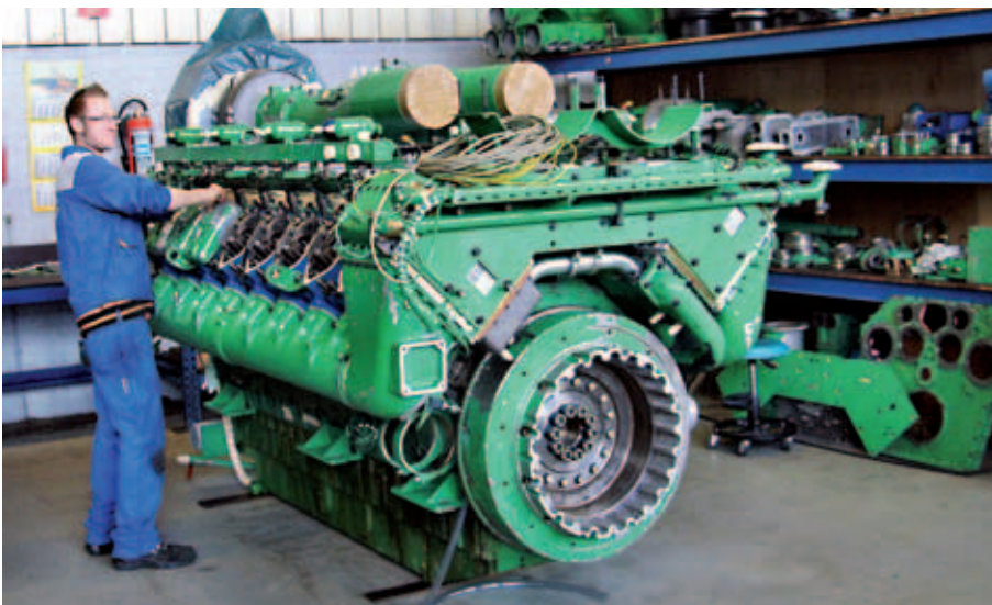
Henkelhausen ist nicht nur Spezialist für die Wartung von Schiffsmotoren, - auch Gasmotoren für die Stromerzeugung werden hier gewartet. Foto Petra Grünendahl
