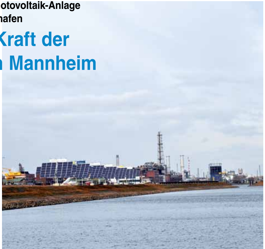
Die neue Photovoltaik-Anlage liefert dem Mannheimer Hafen die Menge Strom, die 243-Zwei-Personen-Haushalten ein Jahr lang reichen würden. Foto: Friedbert Barg
