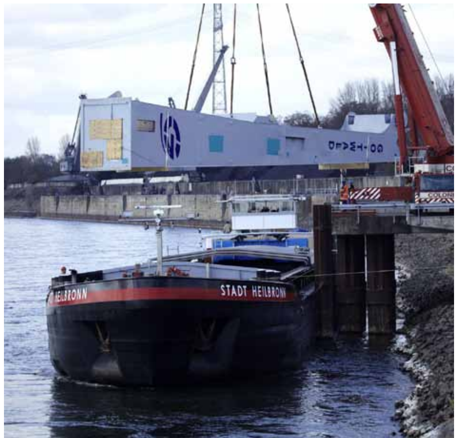
Mit MS „Stadt Heilbronn“ wurde der Kran von Düsseldorf nach Heilbronn gebracht
