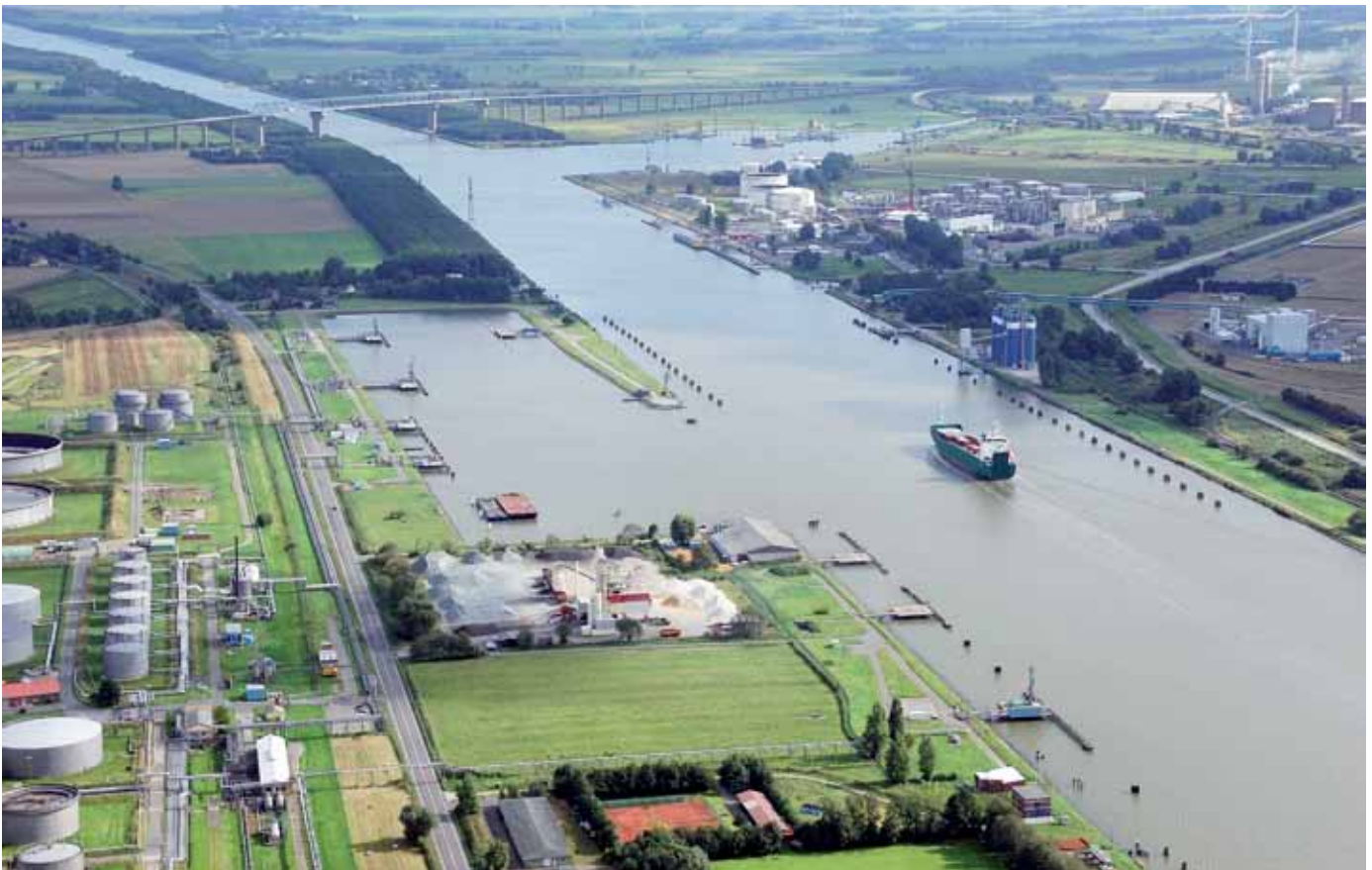
Ausgerichtet als trimodaler Umschlagplatz für See- und Binnenschiffe: Brunsbüttel Ports
