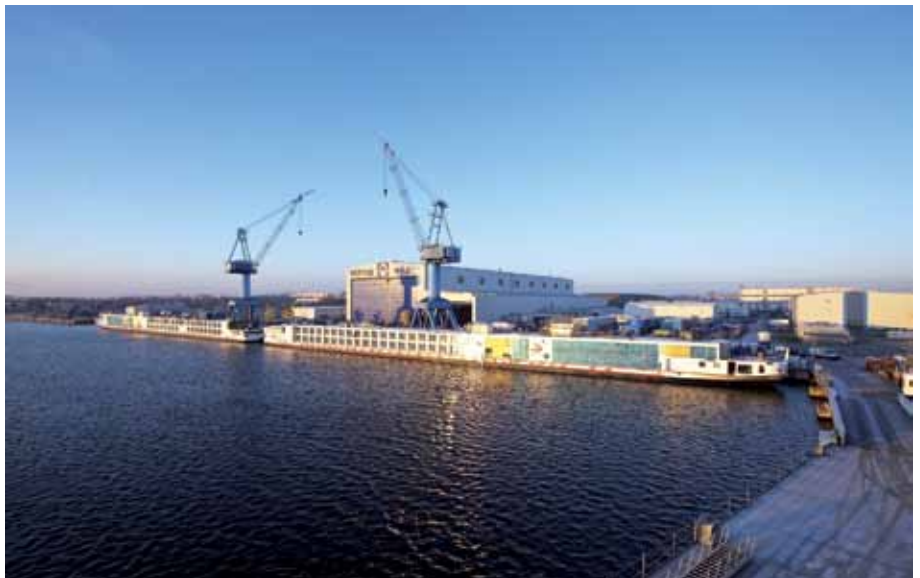
Viking-Neubau vor den Hallen der Neptun-Werft in Rostock.
