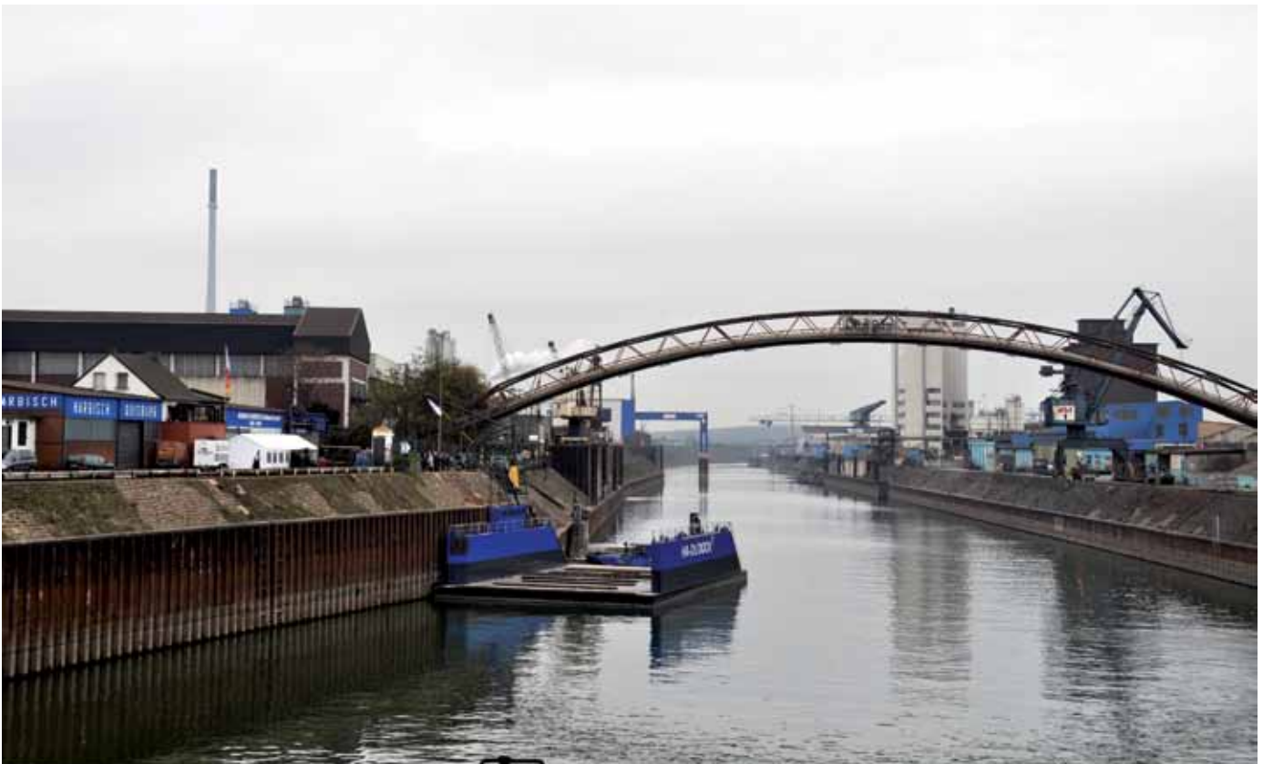
Das neue Trockendock der Harbisch-Werft im Duisburger Außenhafen
