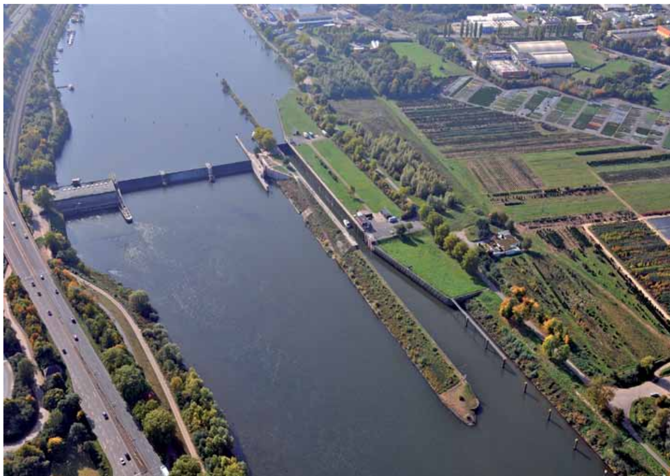
Großes Foto: Luftbild Staustufe Trier; Kartenausschnitt: Vorhafenausbau Schleuse Trier.
