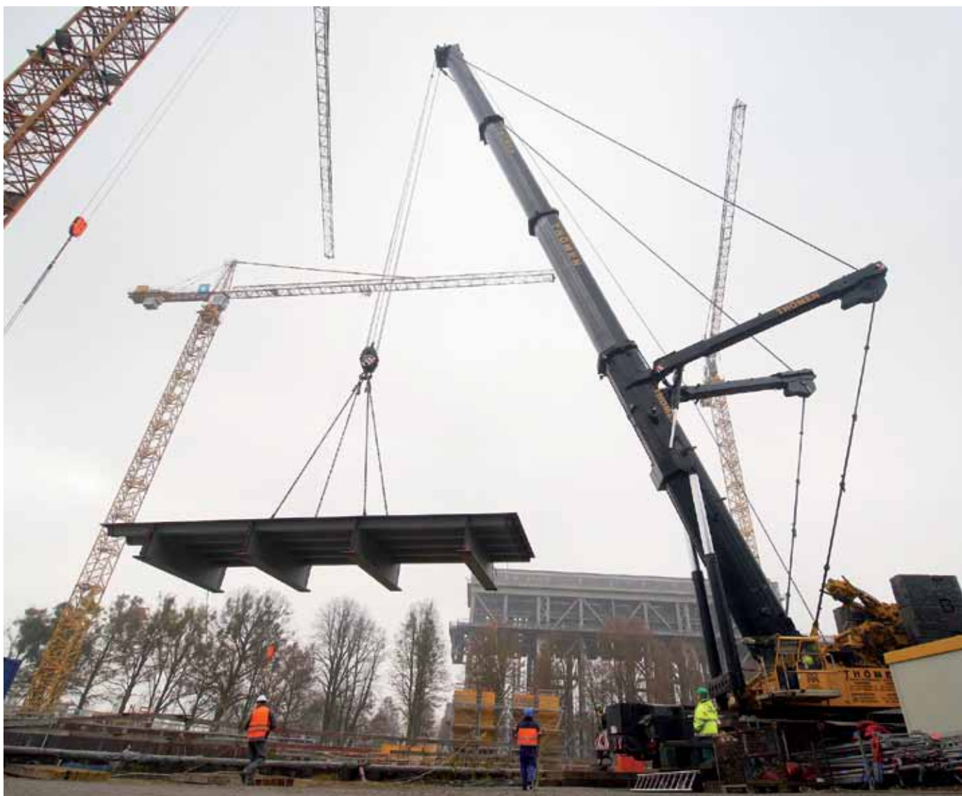
Die Arbeiten am neuen Schiffshebewerk gehen zügig voran.
