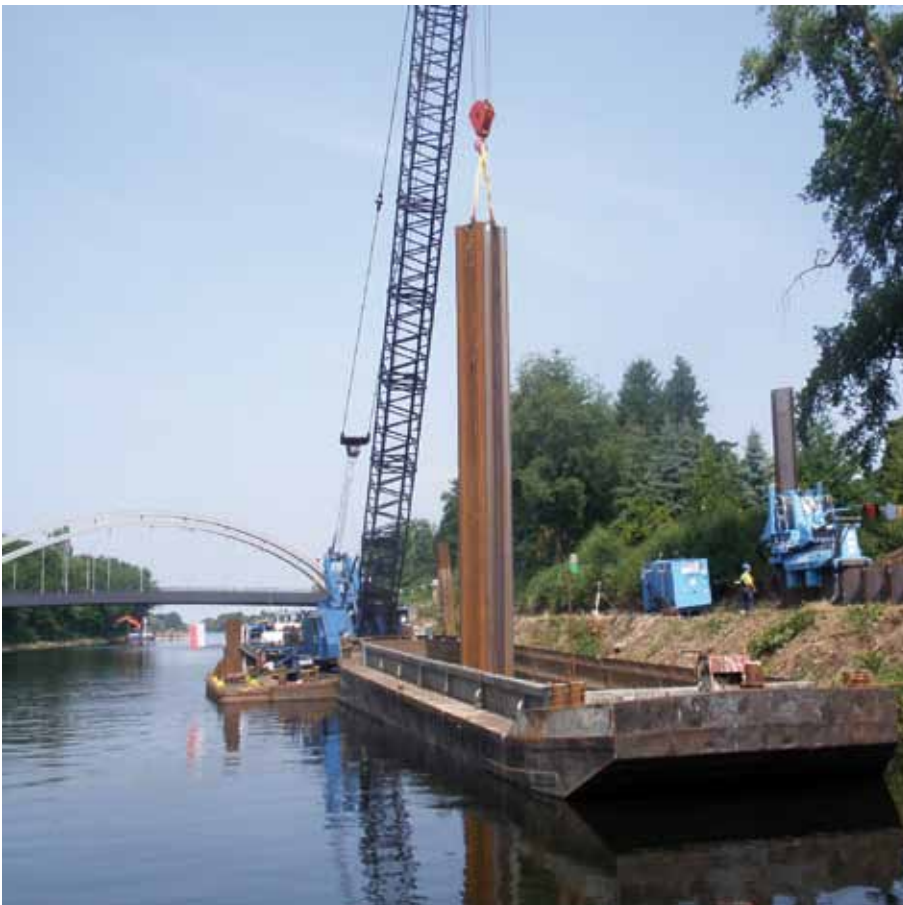
Einpressen von Stahlspundbohlen zur Hangsicherung.
