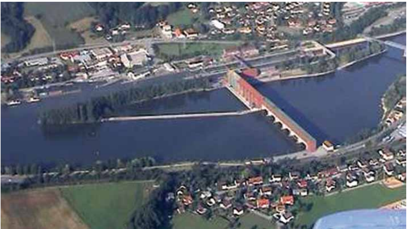
Das Hochwasser im Juni erforderte bereits vereinzelt Notsicherungsmaßnahmen an den Dämmen in der Stauhaltung Kachlet.
