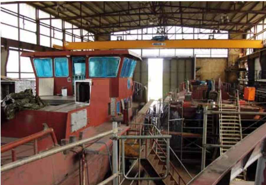
In der großen Schiffbauhalle in Genthin ist das parallele Arbeiten an drei Schiffen der Serie für die BAW möglich
