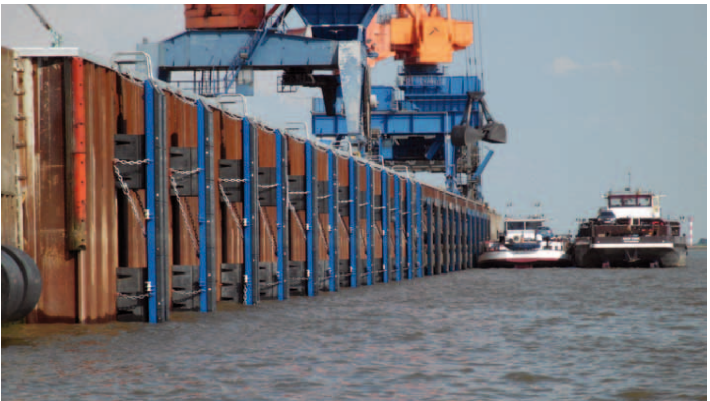
Die neue Spundwand am mittleren Liegeplatz im Elbehafen Brunsbüttel
