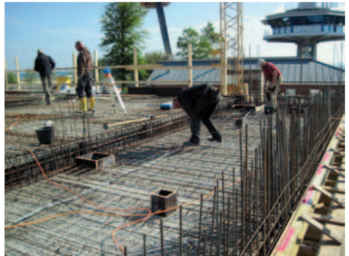
Abb. 9: Bewehrung der Obergeschossdecke
