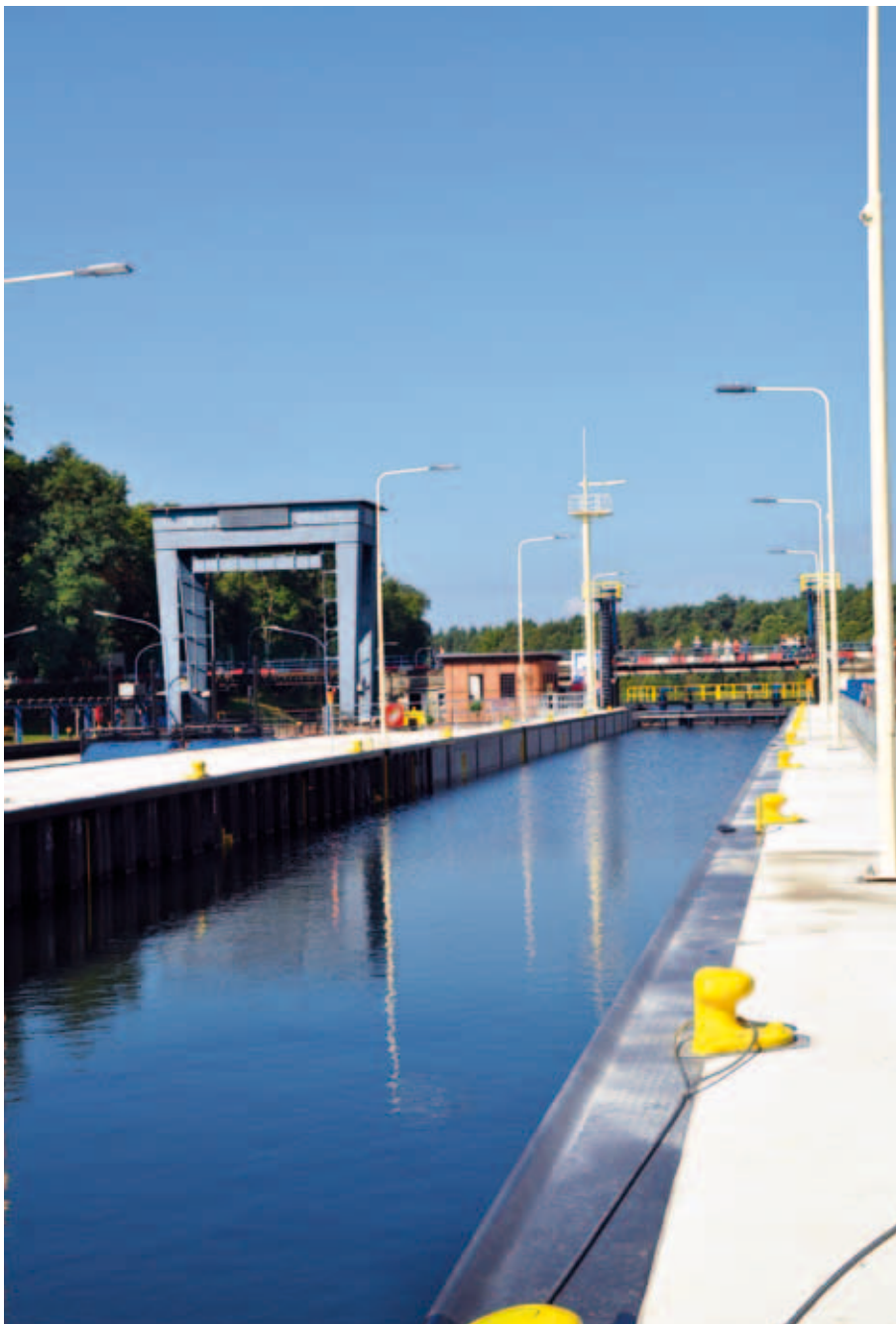
Die fertiggestellte Schleuse Kersdorf am 5. Juni 2013 ...
