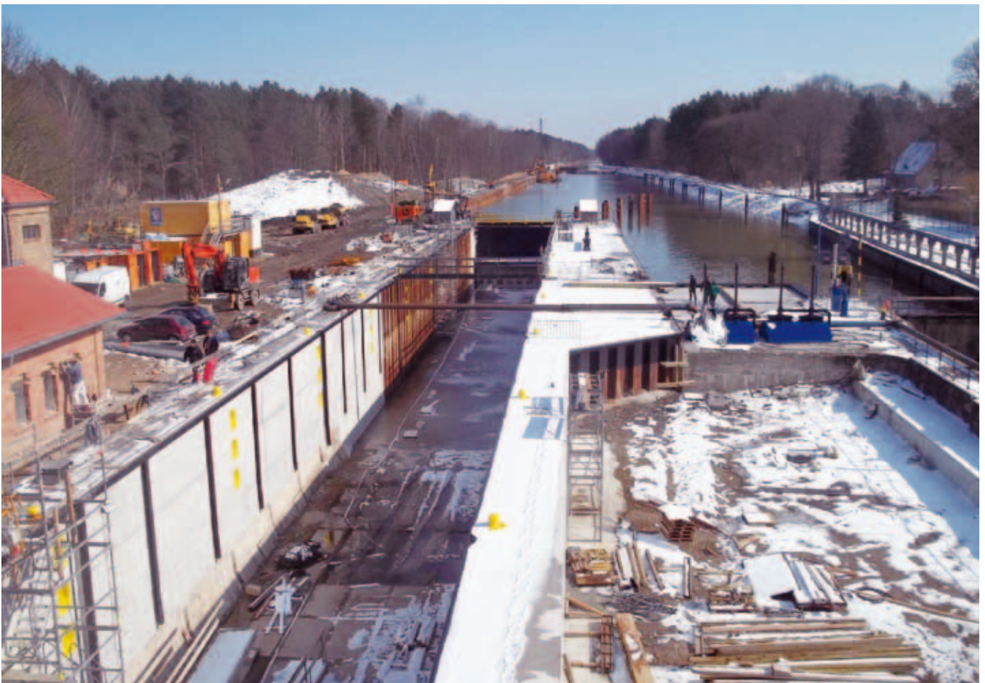
... und während winterlicher Bauarbeiten.
