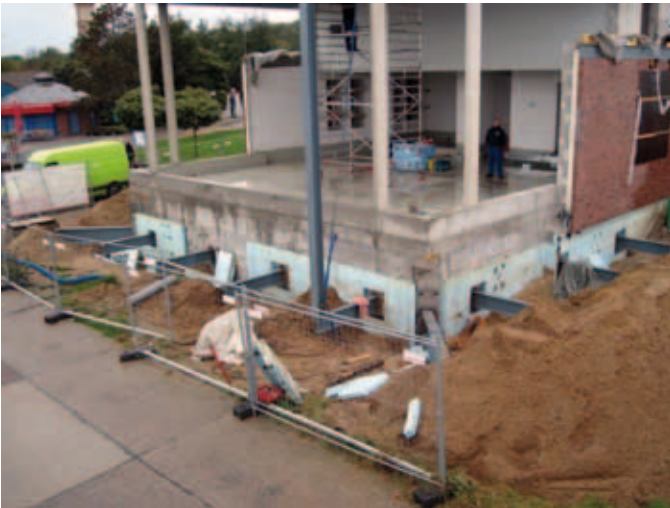
Abb. 8: Kragarme mit der ersten Stütze
