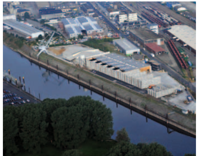
Die neue Zietschmann-Halle im Neusser Hafen
