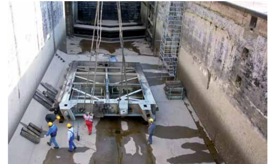
Ein Tor wird zur Instandsetzung in der Schleusenkammer in Gundelsheim abgelegt
