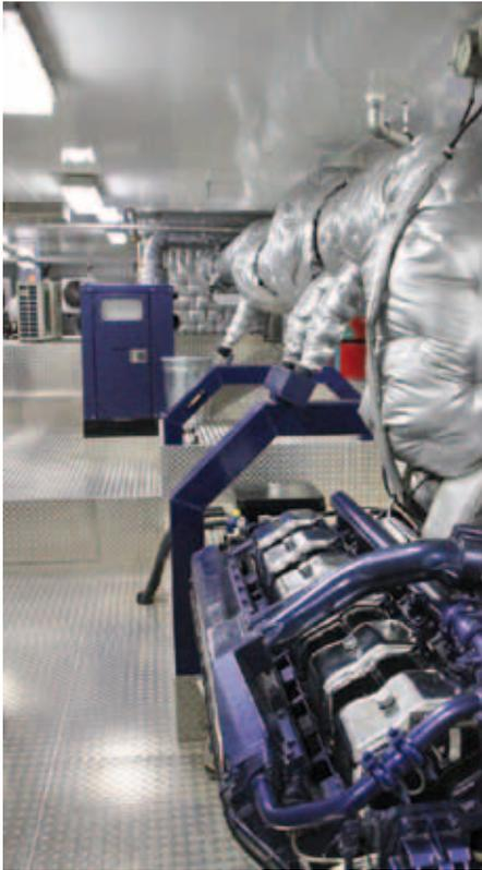
**Einer der beiden kompletten Antriebsstränge. Im Hintergrund sichtbar ein geräuschgekapseltes E-Aggregat**
