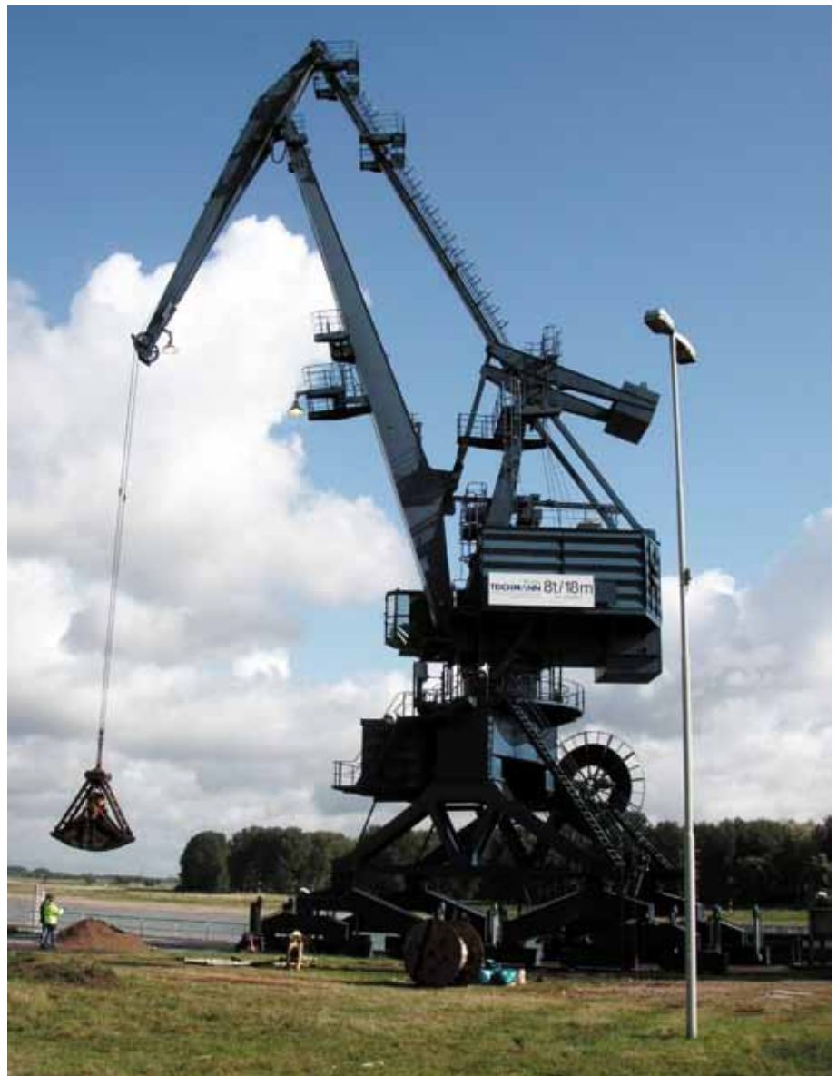
... und ein Teichmann-Drehkran im Einsatz.
