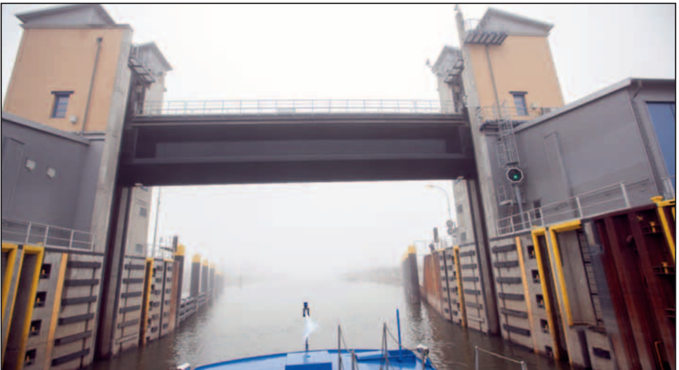
Der Hafen Magdeburg ist nun von den Elbewasserständen unabhängig nutzbar. Die Einweihung der Niedrigwasserschleuse war eine der letzten Amtshandlungen des bisherigen Bundesverkehrsministers Peter Ramsauer. Fotos: BMVI
