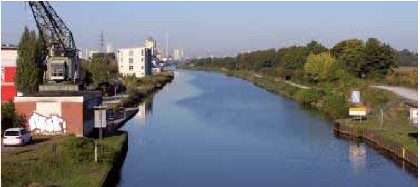
Wird ausgebaut: Der Datteln-Hamm-Kanal.
