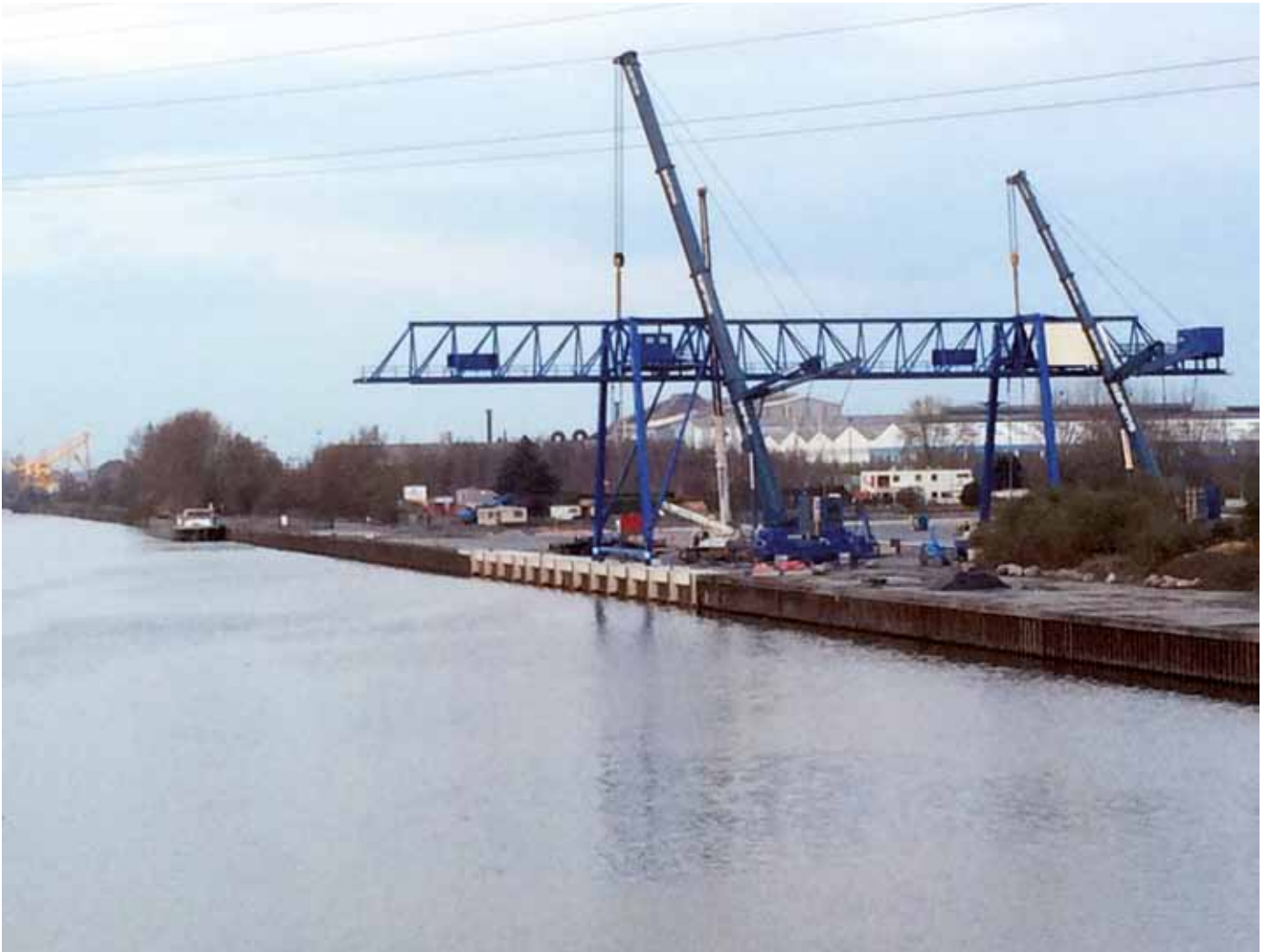
Aufbau der neuen Containerbrücke im Escaut Valenciennes Terminal
