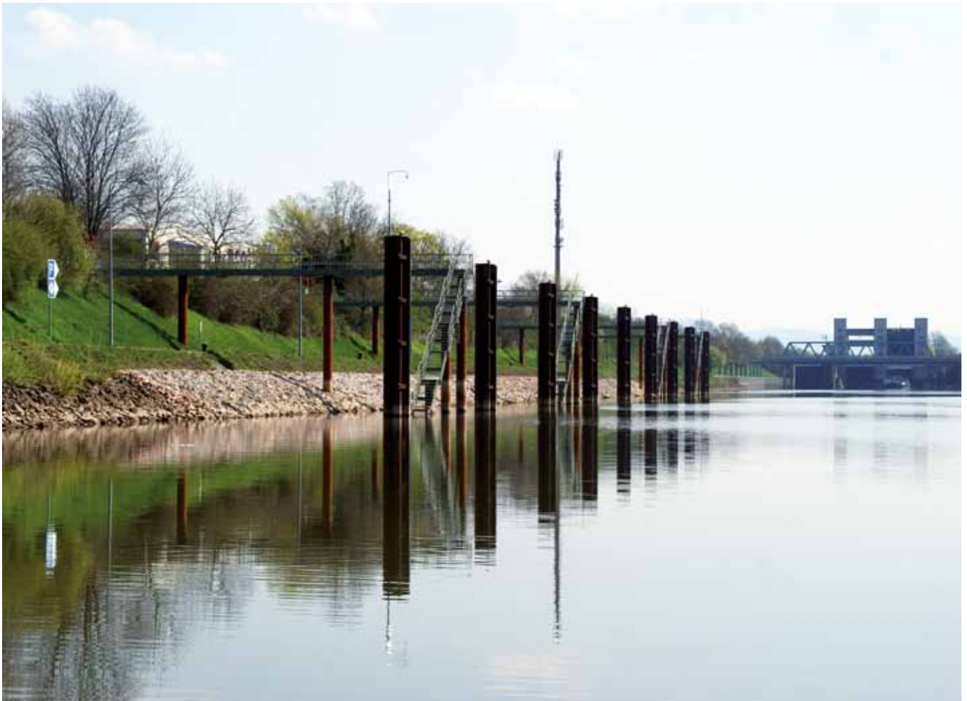
Neue Gefahrgutliegestelle im Unterwasser der Schleuse Feudenheim (im Hintergrund)
