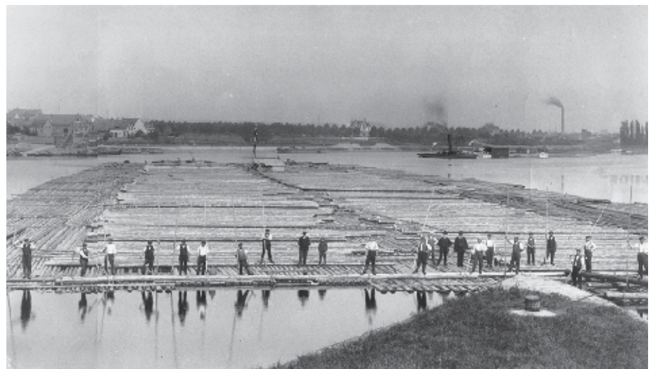
Rheinfloß vor der Abfahrt Höhe Schiersteiner Hafen am 05. Mai 1913 mit den Abmessungen Länge 220 m; Breite 63 m. Das Holz war wie folgt bestimmt: 5398 Stammpfähle für Amsterdam und Rotterdam; 555 Stammgerüsthölzer für Amsterdam und 617 Stamm Meßholz für Düsseldorf und Duisburg. Gebaut und verfloßt durch die Frachtfloßerei Johann Wagner, Mainz-Kastel. Auf den Bild zu sehen sind u.a. der Floßführer Eduard Breitbach, daneben der Floßjunge Eduard Breitbach (1897-1980 - einer der letzten Floßführer) der Flößer Martin Bach und der Steuermann Joh. Wilhelm Breitbach, alle aus Camp
