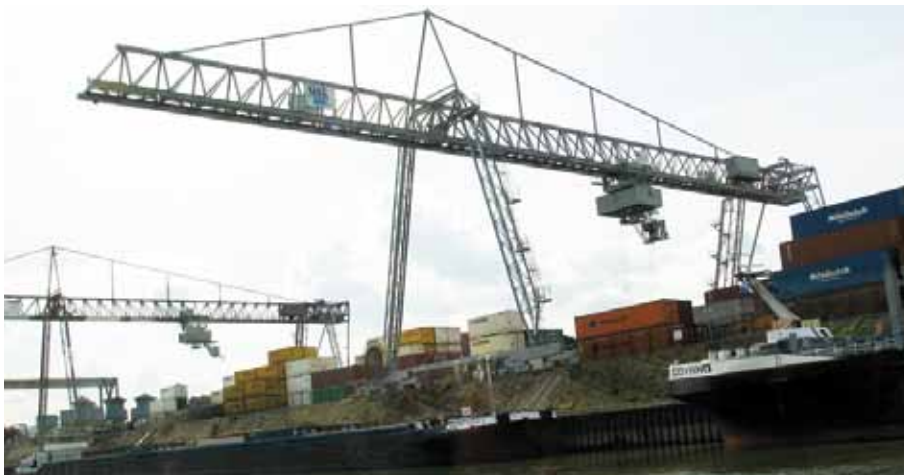
Kranbau Köthen lieferte die neue Containerbrücke.
