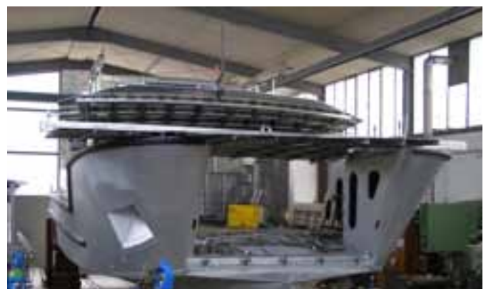
Das im Bau befindliche Hilfeleistungslöschboot (HLB) HECHT für die Feuerwehr in Gernsheim am Rhein.
