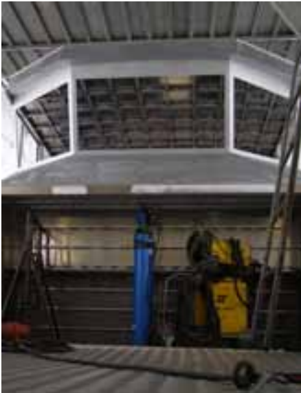
HLB HECHT nach weiterem Baufortschritt auf der Neckar-Bootsbau Ebert GmbH
