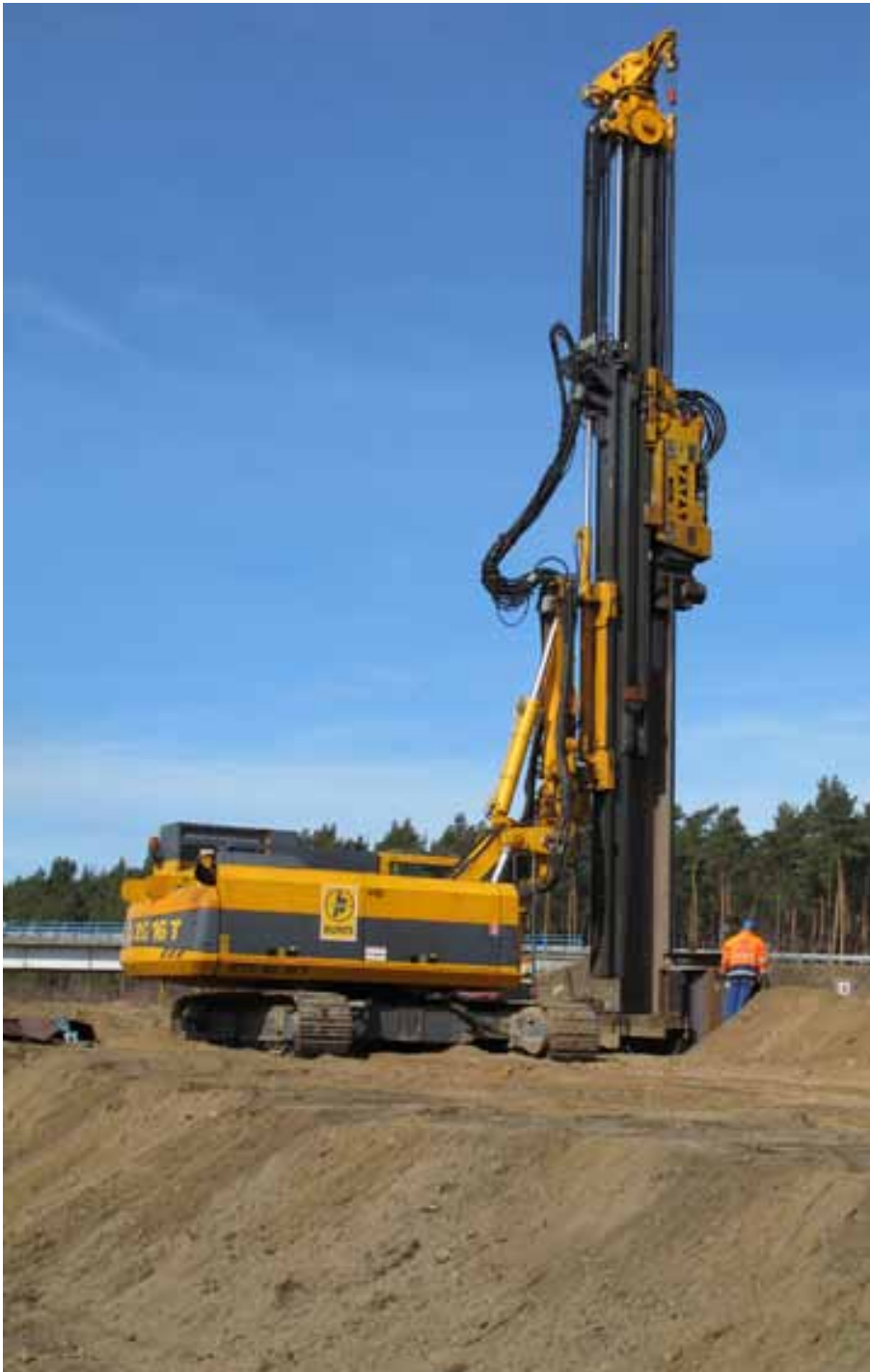
Die Spezialmaschine für den ersten Rammschlag.
