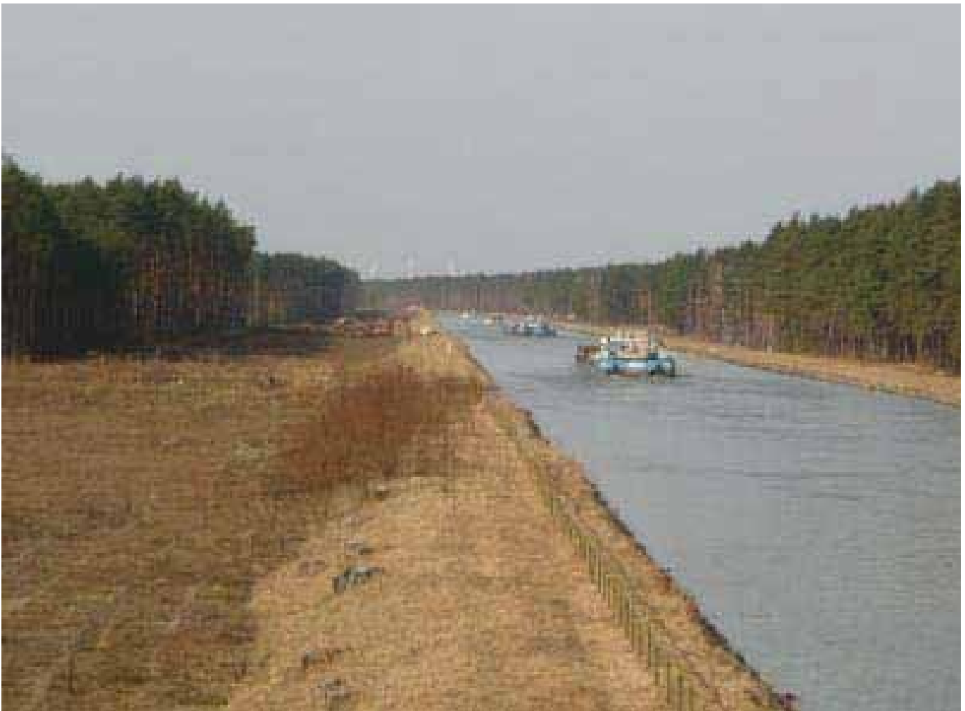
Blick auf die Havel-Oder-Wasserstraße. Auf der linken Seite erfolgt die Verbreiterung.
