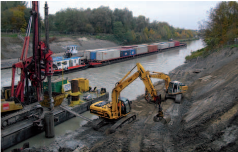
Vorbohren der Spundwandtrasse
