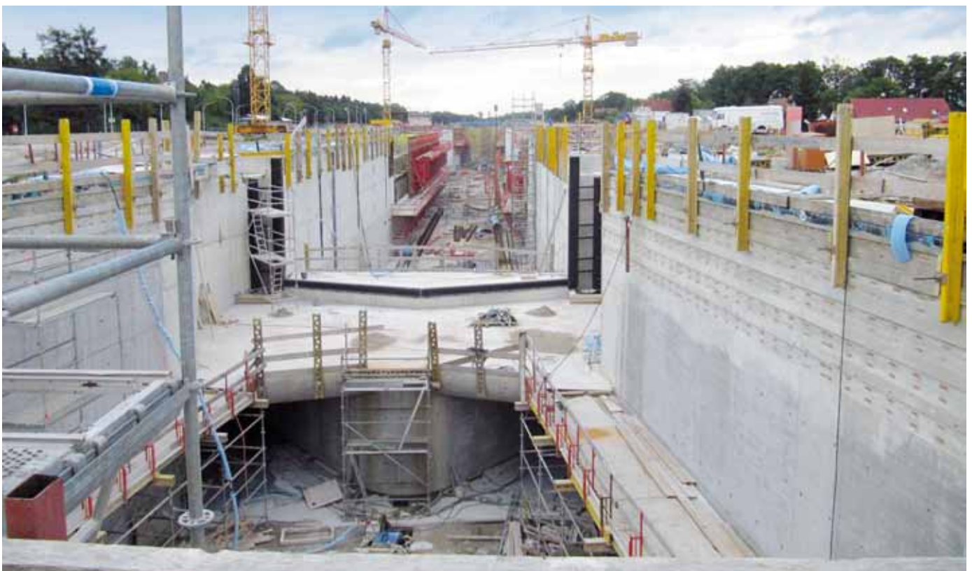
Blick in die Baugrube im August 2011.
