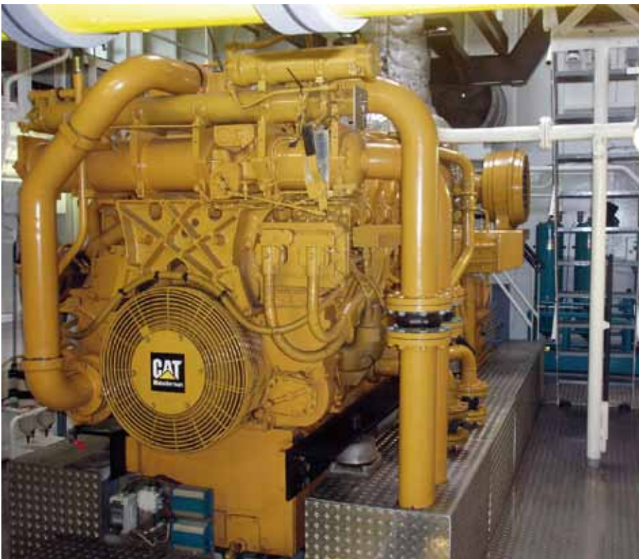
„Herkules XVI“ verfügt über 3 Caterpillar-Hauptmaschinen á 2.020 PS. Foto: G. Strack
