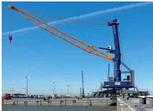
Mobilkran von Liebherr im Eemshaven.
