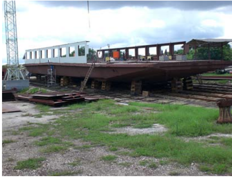
Foto: NRSW Abb. 4: Montage der Aufbauten im April 2008.
