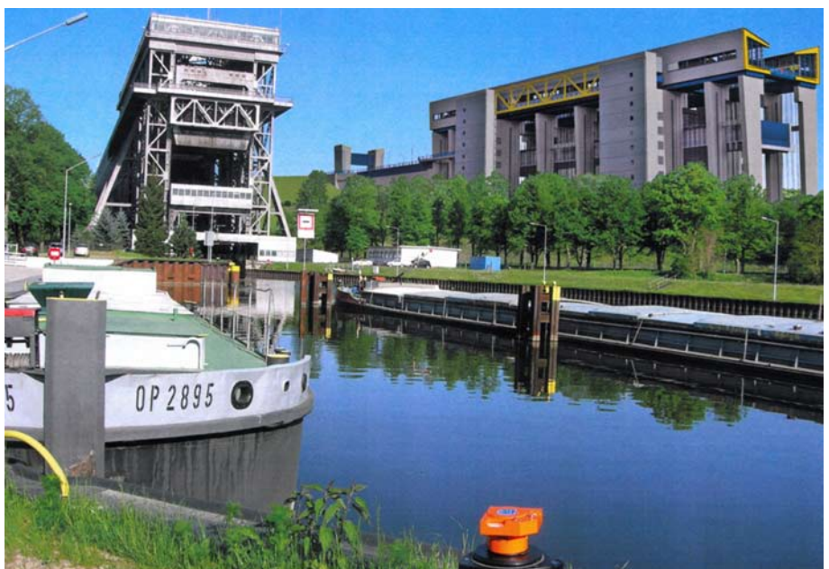
Blick auf die beiden Hebewerke
