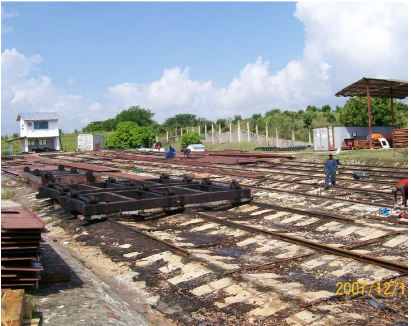
Abb. 2: Erneuerungsarbeiten an Längshelling und Hellingwagen Ende 2007.
