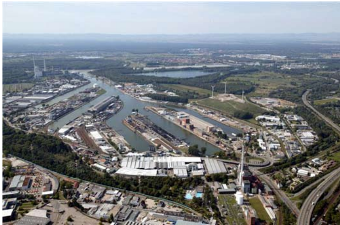
Die Karlsruher Hafenanlage
