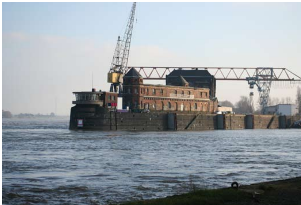
An der Hafenspitze in Krefeld werden die letzten Arbeiten am neuen Containerterminal beendet.
