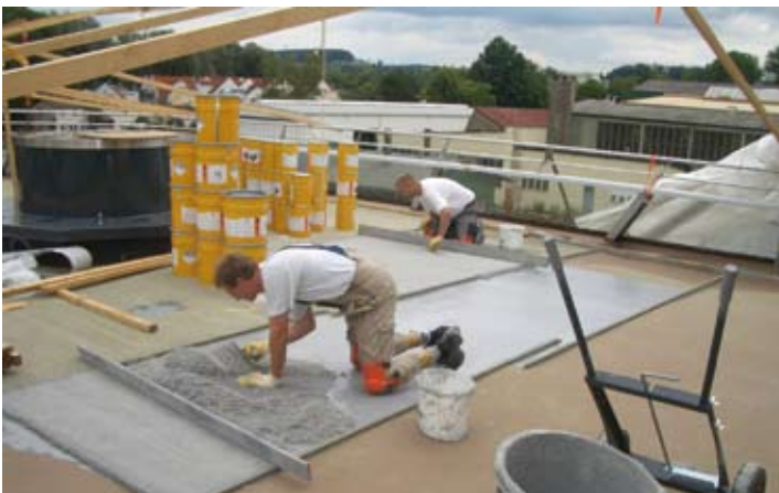
Aufbringung des Estrichs im Außenbereich ...
