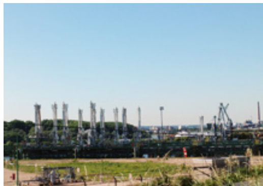
Zum Ausbau des Godorfer Hafens hat die HGK Informationen ins Internet gestellt. Foto: F. Barg
