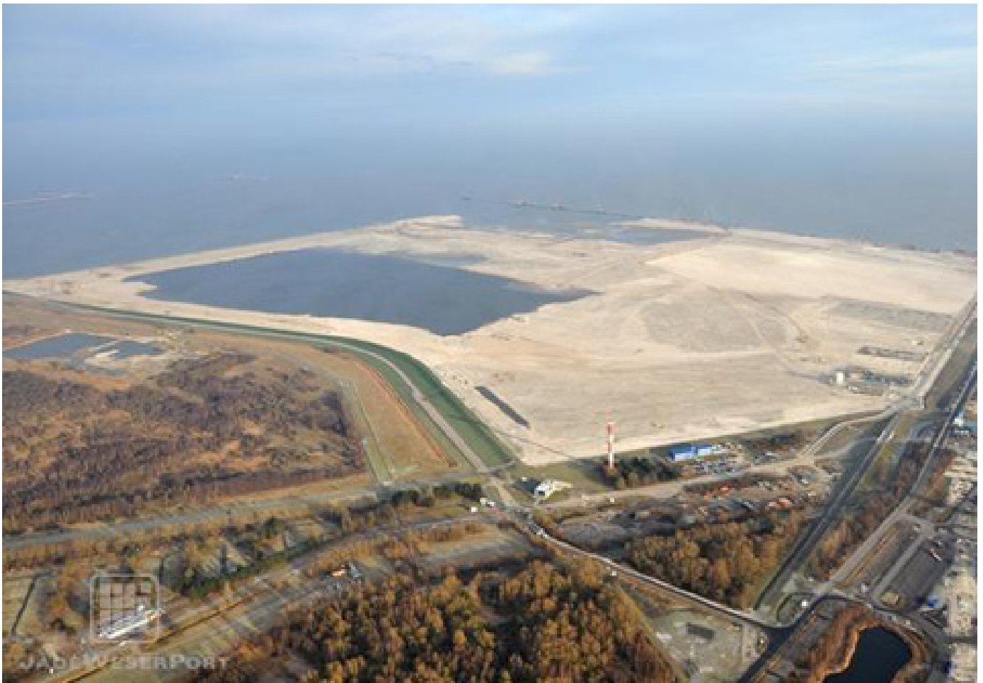
Luftaufnahme vom Ausbau des JadeWeserPorts aus dem Dezember 2009.
