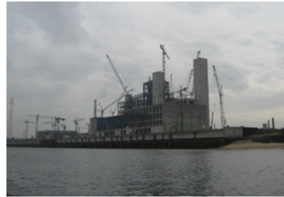
Um das geplante Kohlekraftwerk im Hamburg-Moorburg (hier der Rohbau) gibt es noch Auseinandersetzungen mit Klima- und Umweltschützern. Weitere Kohlekraftwerke sind geplant. Foto: Sabine Homann
