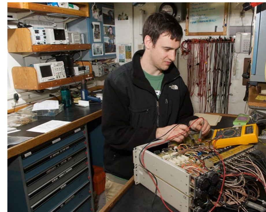
Überprüfung eines Sicherungskastens
