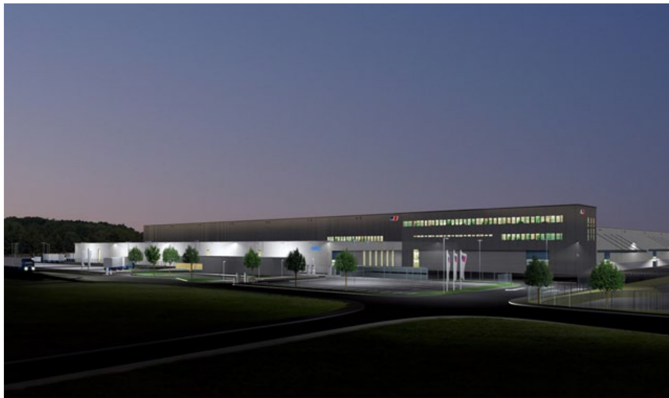
Das MTU-Materialwirtschaftszentrum in Kluftern nahe Friedrichshafen wird künftig die Produktion der Tognum-Tochtergesellschaft MTU Friedrichshafen und weitere Standorte der Tognum-Gruppe mit Produktionsmaterial versorgen. Ab Anfang des Jahres 2012 wird es stufenweise seinen Betrieb aufnehmen. Seit dem 5. August 2010 laufen die Bauarbeiten
