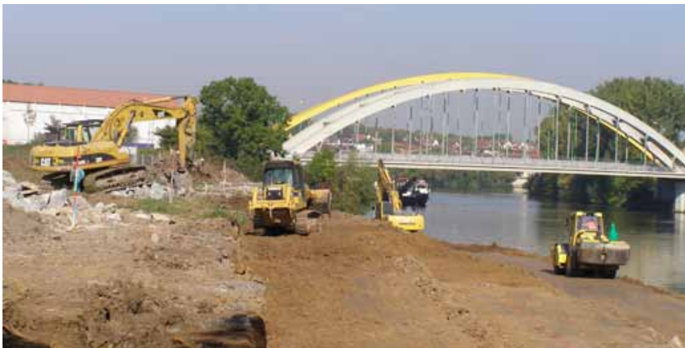
Bauvorbereitungen für das Heilbronner Containerterminal am Altneckar-Stromhafen
