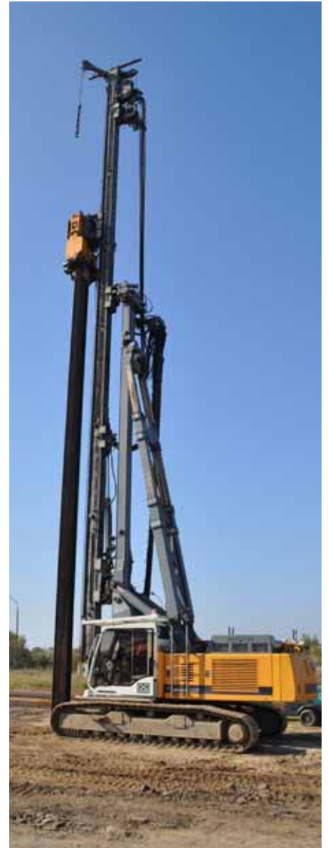
17 m tief wird die Spundwand eingrammt. Fotos: Friedbert Barg
