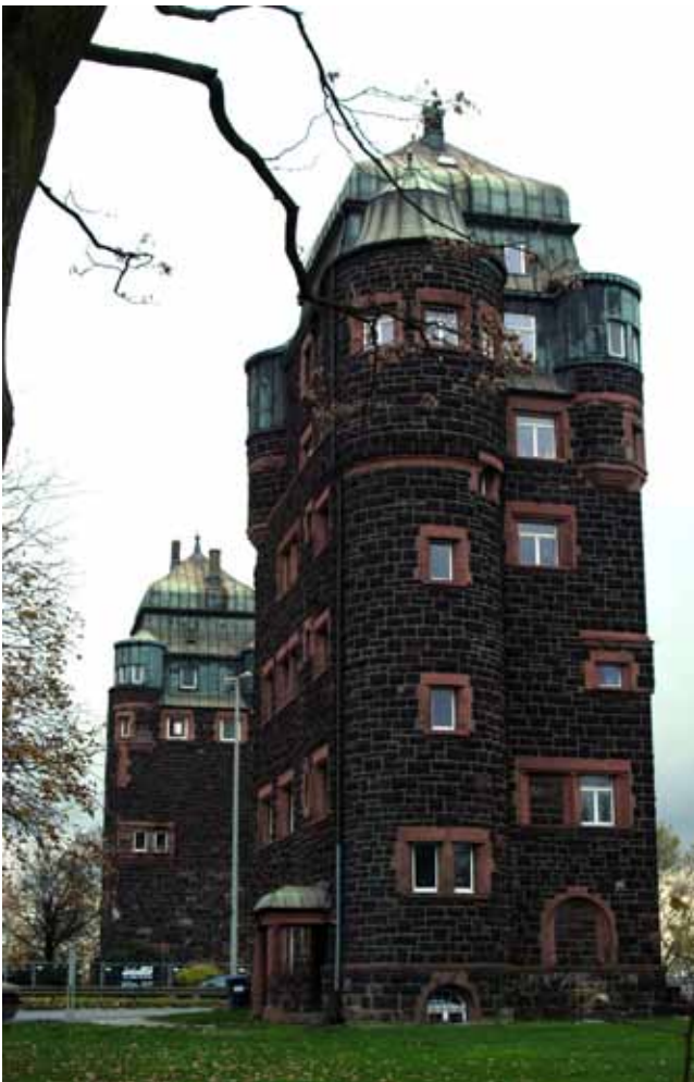
Die beiden Brückentürme an der Zufahrt zur Friedrich-Ebert-Brücke von Duisburg-Ruhrort nach Homburg
