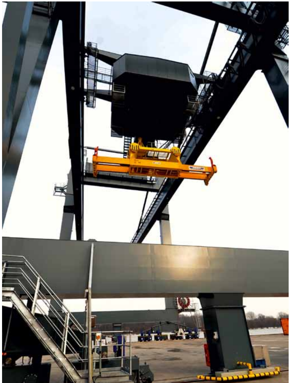
600 Tonnen schwerer Koloss: Die neue, zweite Containerbrücke der Am Zehnhoff-Söns GmbH steht im südlichen Teil des Bonner Hafens und ist eine der größten am Rhein
