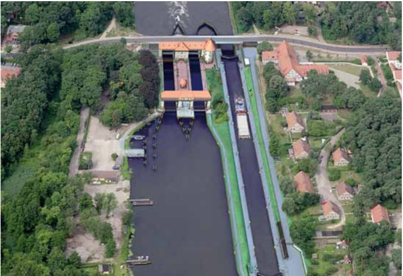
In diesem Simulationsbild zeigt das WNA Berlin die Schleuse Kleinmachnow bereits mit der Kammer von 185 m Länge
